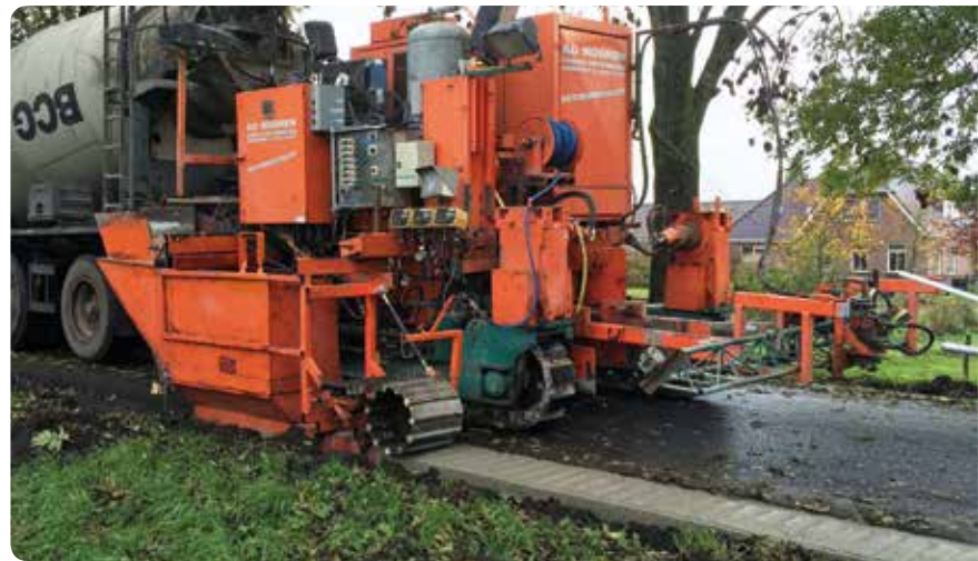
Het bedrijf heeft smalle (0,50 tot 2,50 meter) en brede (2,50 tot 5,00 meter) pavers om verschillende breedtes te realiseren en heeft de smalle paver geschikt gemaakt voor bermbeton.
