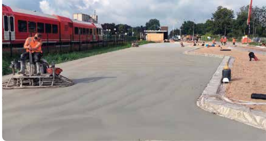
Ad Nooren heeft zich ook gespecialiseerd in betonverhardingen van bedrijfsterreinen en bedrijfshallen. Hier de nieuwste hydraulische vlindermachine in actie bij een bushalte.
