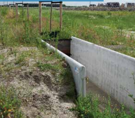
De proefopstelling met de jonge aanplant in een betonnen sleuf.
