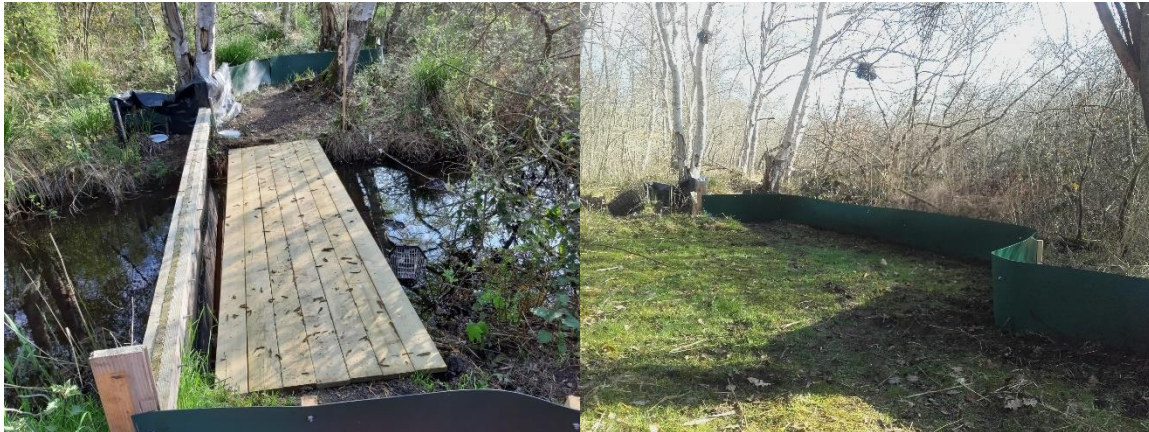
Afbeelding 2.2: Aan de linkerkzijde het damwand waarmee de Distelvinkplas is afgesloten van de rest van de Molenpolder. Aan de rechterzijde een deel van het amfibiescherm.
