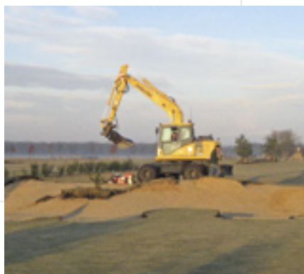
Plaggen leggen in de MacKenzie bunker.
