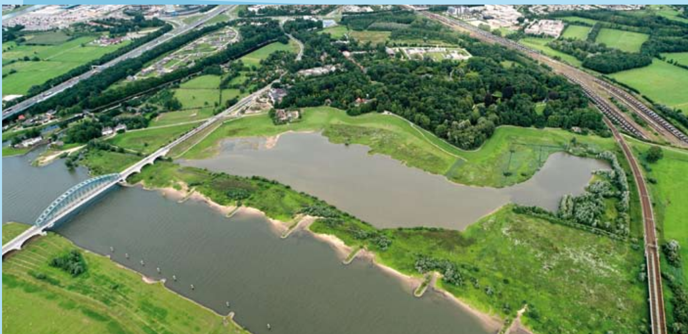
Het project Engelse Werk aan de IJssel bij Zwolle.
