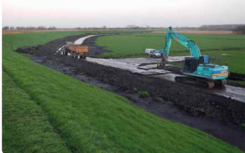
Soms moet er werk gedaan worden op minder draagkrachtige grond. Speciaal daarvoor beschikt het bedrijf over drieduizend rijplaten.
