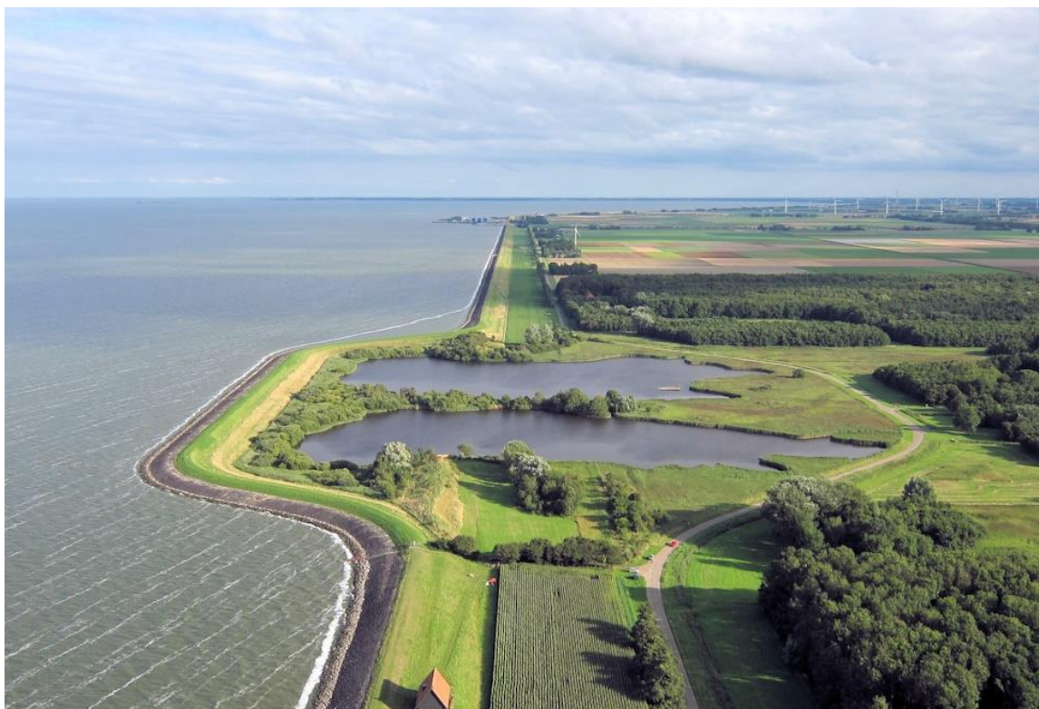
In april 1945 werd de dijk van de Wieringermeer door de bezetters opgeblazen, waardoor gaten van 150 en 200 m breed en 20 en 26 m diepte ontstonden (Vliegerfoto: Tom Kisjes).
