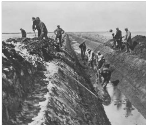
Figuur 2.6 (links) Handmatig graven van een sloot (Terpstra 1980)
