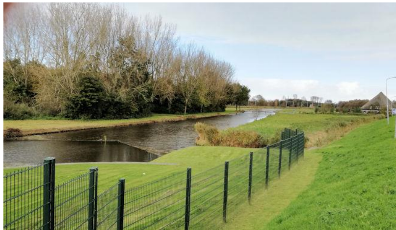
Figuur 14.3 De noordelijke inlaat (-3,20 m) van het gemaal Westerkogge (foto: Herman van Dam)
