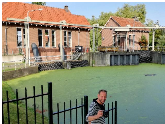
Figuur 13.3 Dik kroosdek op locatie 61006 De Kolk, Hoorn, voor krooshek gemaal Oosterpolder. Foto: Herman van Dam.
