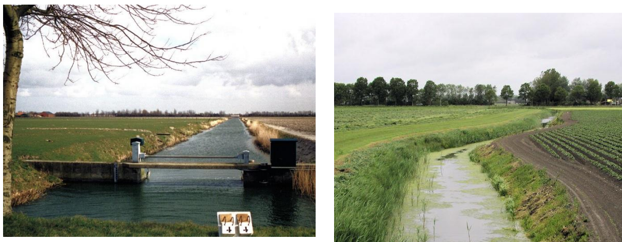
Figuur 7.2 Links: locatie 375103 Afwatering van de Ringpolder bij de stuw Kalverdijk. Rechts: locatie 375702 Rekerkoogweg bij de eerste brug vanaf het Noordhollandsch Kanaal (Foto's HHNK).
