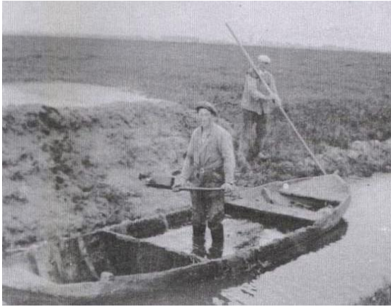
Figuur 12.5 (links) Het baggeren van de sloten in de Drieban vóór de ruilverkaveling. De bagger werd in de winter vanuit de schuit op de wal gehoosd achter een kade, die van enkele steken grond was opgezet. Na de winter werd de ingedroogde bagger als vruchtbare grond over het land verspreid, waardoor men minder kunst- of stal-mest hoefde te gebruiken. De bagger werd met de baggerbeugel in de schuit gebracht, tussen twee schotten. Bij dikke bagger werd een net gebruikt, en bij dunne bagger een zak. Deze werden met een leren veter of een palingvel aan de beugel bevestigd (De Waal 2009).
