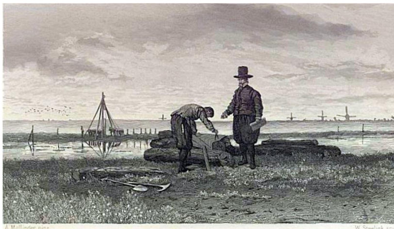
Figuur 12.2 “Jan Adriaensz. Leeghwater houdt toezicht bij de bouw van de watermolens in de Beemster. 16 Links worden heipalen geslagen in een opgeworpen dijk” Tekening van Taco Scheltema naar het originele schilderij van A. Mollinger (1836-1867), gravure door W. Steelink, uitgeverij A.W. Sijthoff, ca. 1880. Het originele schilderij van Mollinger is afkomstig uit de Historische Galerij van Arti et Amicitiae, het Amsterdamse kunstenaarsgenootschap, en bevindt zich thans in het Purmerends Museum ( www.poldersporen.nl ).
