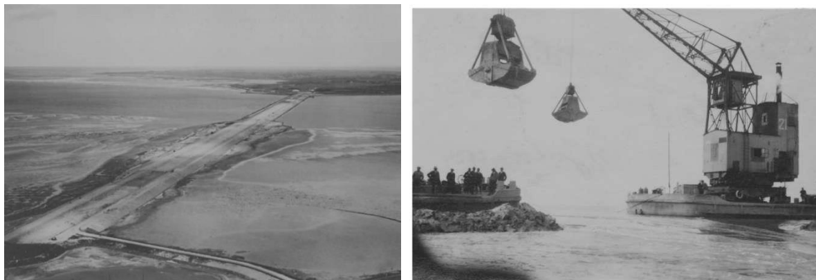
Figuur 8.4 Amsteldiepdijk met aan beide kanten verzakkingen in 1925 ( Beeldbank Historisch Genootschap Wieringermeer ).
