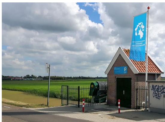
Figuur 3.16 Gemaal Vennewaterspolder (Foto: Edwin Raap, beeldbank.cultureelerfgoed.nl).
