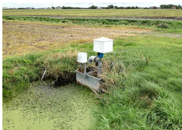
Figuur 3.22 (links) Door het beschikbaar komen van kleine elektrische pompjes is het aantal peilvakken (vaak met onderbemalingen) sterk toegenomen. Hier wordt het bruine veenwater geloosd op een randsloot van de Polder Westzaan (NGJ).
