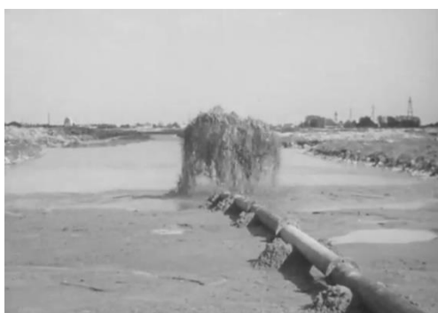
Figuur 3.19 (links) Het opspuiten van zand in een vaarsloot van de Polder Hensbroek ( Veenhuysen 1961 ).
