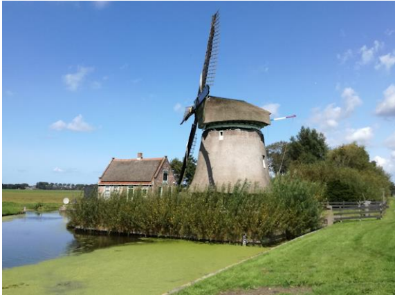
Figuur 3.14 (links) Molen 153 (PV) bij 't Zand dateert uit de 17 e eeuw en was tot 1966 in bedrijf voor bemaling van de Zijpe- en Hazepolder (HvD).
