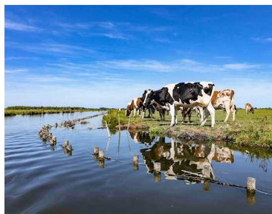
Figuur 5.16 Door veenafbraak zakken de oevers van veensloten in. In deze sloot ten oosten van Landsmeer is beschoeiing geplaatst om dempen van de sloot te voorkomen (HvD).
