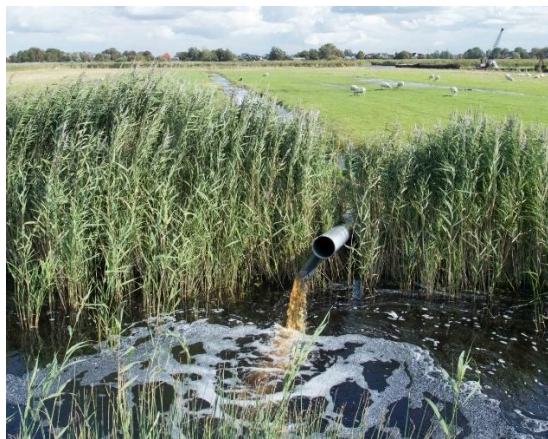
Figuur 3.22 (links) Door het beschikbaar komen van kleine elektrische pompjes is het aantal peilvakken (vaak met onderbemalingen) sterk toegenomen. Hier wordt het bruine veenwater geloosd op een randsloot van de Polder Westzaan (NGJ).
