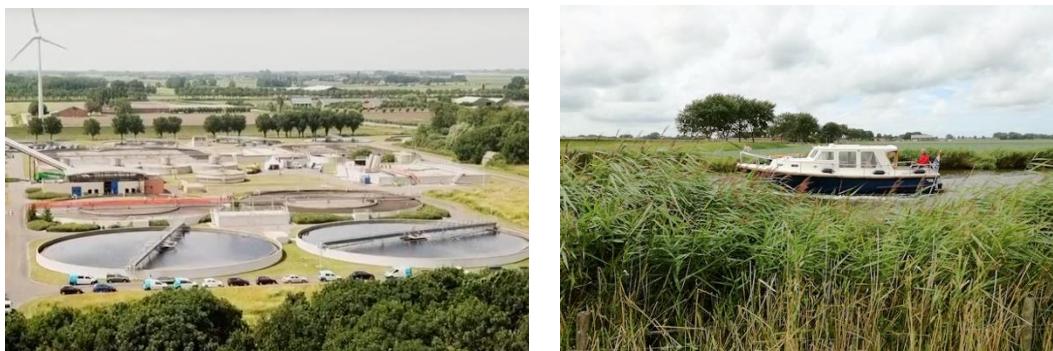
Figuur 4.16 (links) Rioolwaterzuiveringsinrichtingen lozen hun effluent vaak op boezemkanalen (HHNK)
