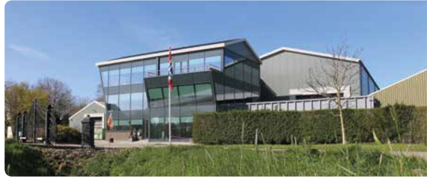
Het indrukwekkende kantoorpand aan de rand van Oldenhove.
