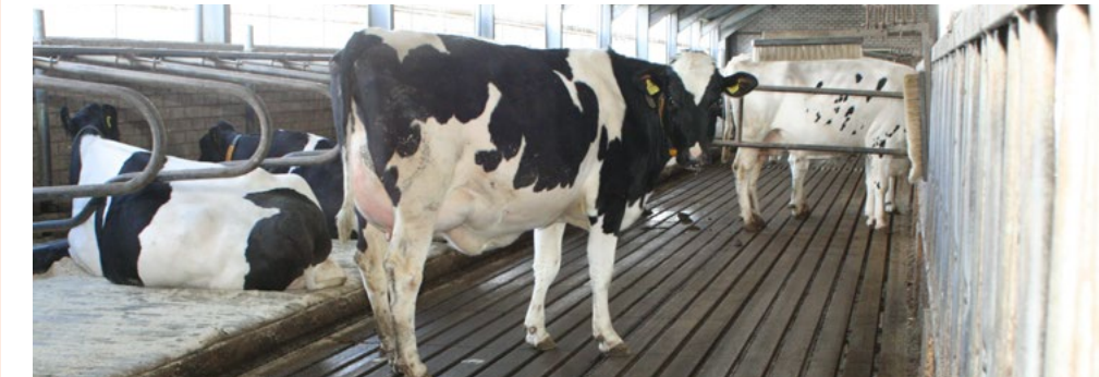
Een emissie-arme vloer (hier op De Marke) draagt bij aan minder ammoniakuitstoot.
