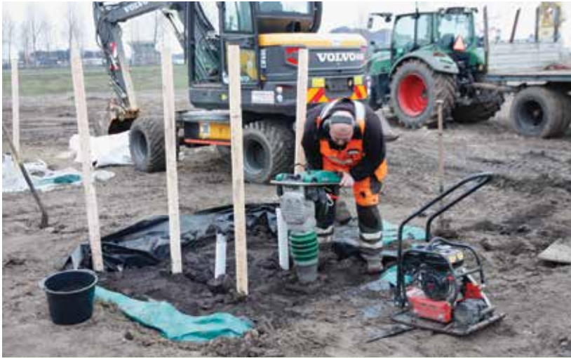
Kiwa KOAC heeft per groeimedium onderzocht hoe de diverse groeimedia het best verdicht kunnen worden tot de vereiste verdichtingsgraad. Aannemer TC Groentechniek verdicht de groeimedia daarom met verschillende laagdiktes en verdichtingstechnieken.
