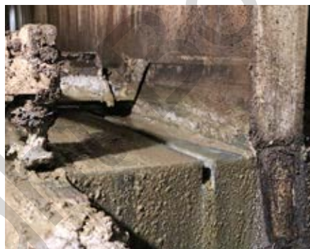
De urine wordt meteen afgevoerd via een kleine goot. Zo komt die niet in contact met de mest en wordt er minder ammoniak uitgestoten.
