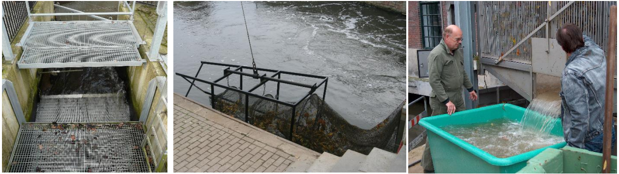
De vangconstructies bij de ECI wkc: de smoltval (links), de aalfuik (midden) en de vangkooi (rechts)(foto's Thijs Belgers).
