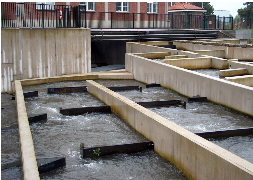
De vertical slot vispassage bij de ECI wkc (foto: Thijs Belgers).
