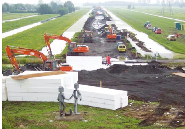
Figuur 39: Aanleg weg op EPS (polystyreen)
