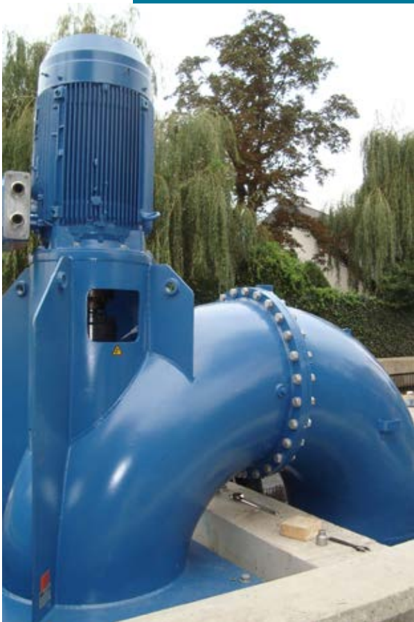
Plaatsing van een visvriendelijke pomp in de Mijndense sluis.
