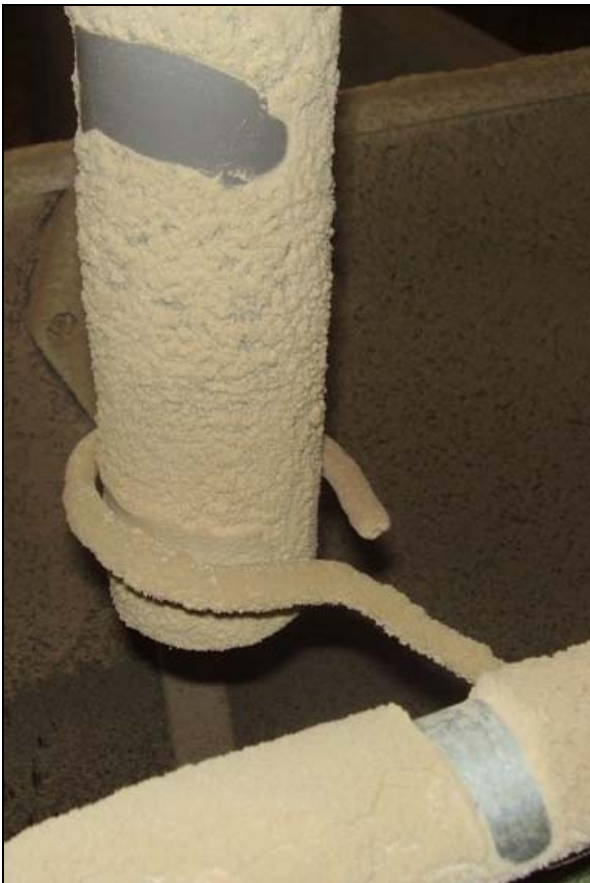
N. Detailfoto van stof aan een stortpijp en op de rand van een hokafscheiding; een deel van het stof is weggeveegd om de stoflaag te tonen
