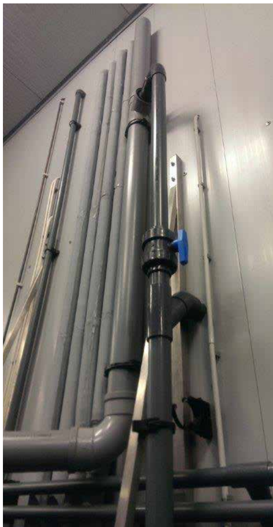
Ontluchtingspijpen op ARF te Wageningen. Zij dienen om te hoge drukopbouw tegen te gaan en om gassen te laten ontwijken, ter vermijding van 'gass bubble disease'.
