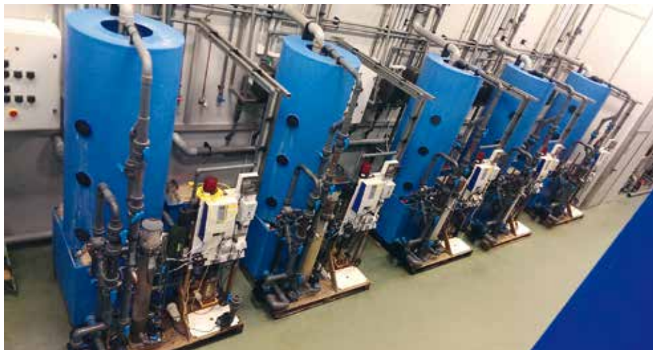
De vier identieke filters voor de recirculatie systemen in de voor aquacultuur gebruikelijke kleur blauw. Foto: Carus.
