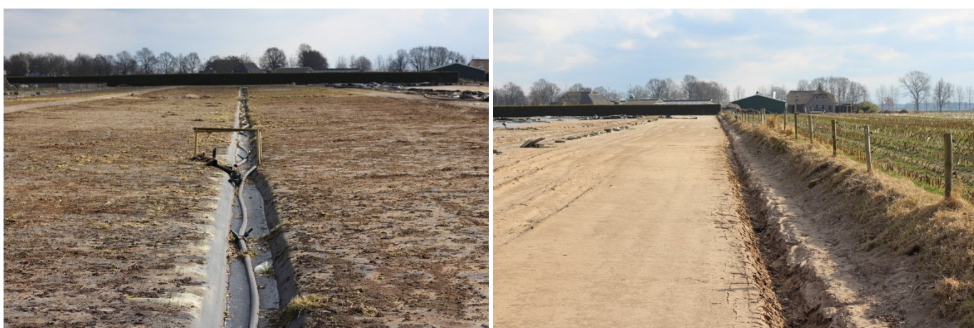
Figuur 5. Het midden en de zuidzijde van het plangebied vanuit het westen gefotografeerd.
