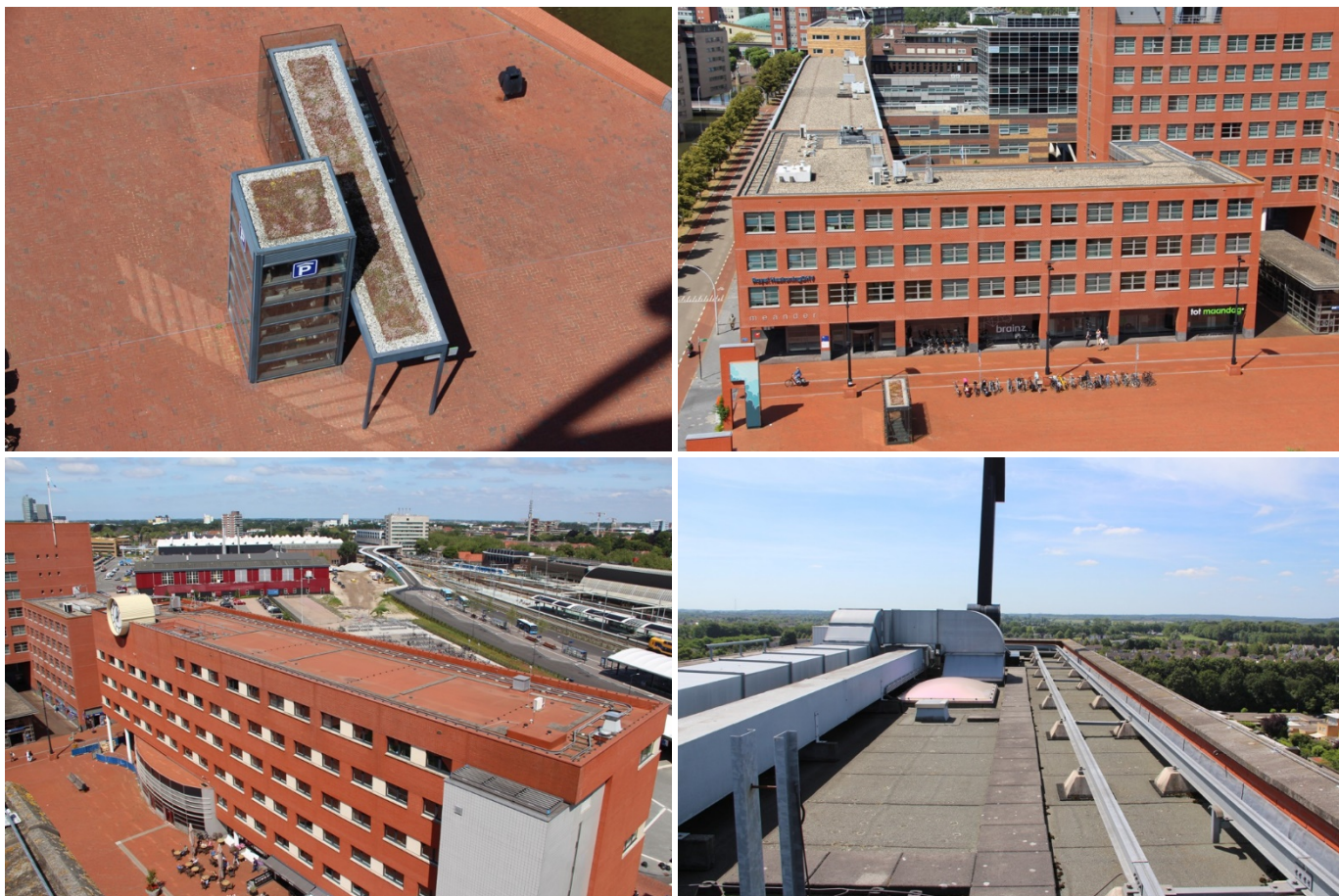
Figuur 16. De foto linksboven laat zien dat de ingang van de parkeergarage een sedumdak heeft. De overige daken rondom het Lübeckplein van gebouw Meander, Schellepoort en Stadskantoor hebben geen groendak met uitzondering van een klein sedumdak op het Stadskantoor, zie figuur 20.
