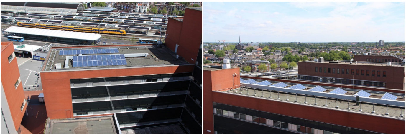
Figuur 19. Zonnepanelen op het Stadskantoor.
