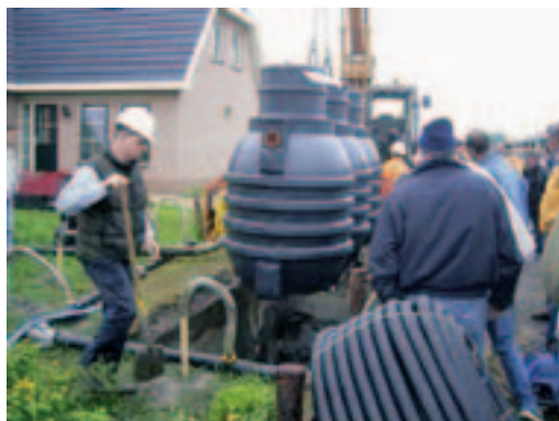
Het plaatsen van de IBA.
