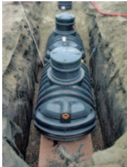
Het plaatsen van de ondergrondse IBA.
