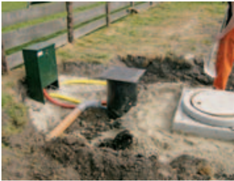
IBA geplaatst en afgedekt met grond.
