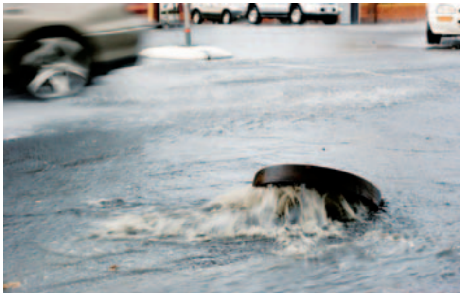
Overstromende riolering door noodweer.
