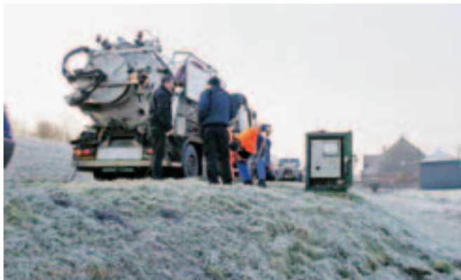
Onderhoud aan persleiding en gemaal.
