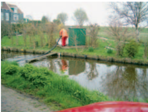
Inspectie van een bestaand rioolgemaal.
