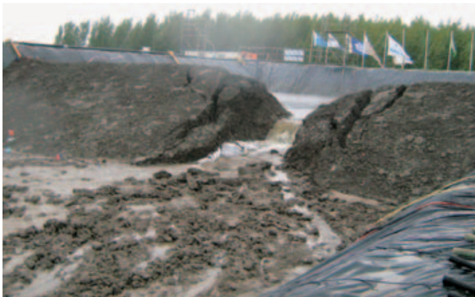
Feestelijke dijkdoorbraak tengevolge van piping.
