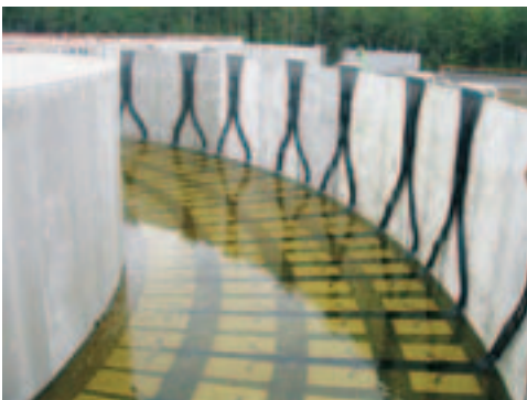
Figuur 3: Plaatbeluchting in ronde beluchtingtank rwzi Eindhoven.
