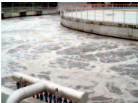
Figuur 3: Plaatbeluchting in ronde beluchtingtank rwzi Eindhoven.
