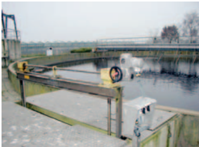
De aflaatklep van de rwzi Bennekom.
