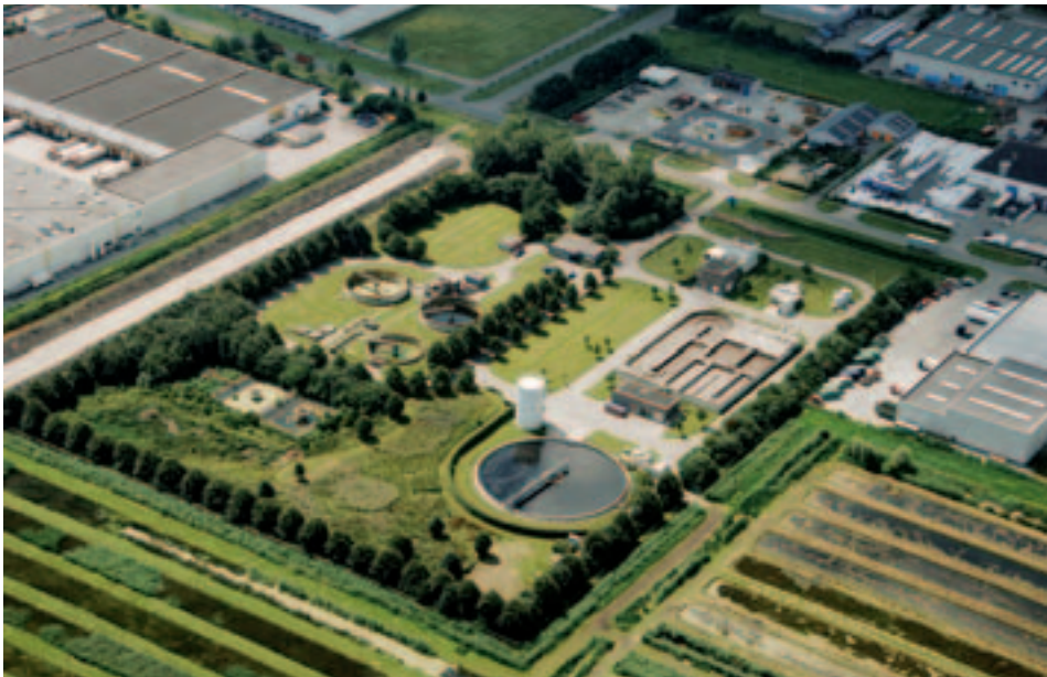
De rwzi Zeewolde (35.000 i.e.) met rechts boven de beluchting en de nabezinktank en links onder de oude zuivering, nu het ‘Cannibal’ gedeelte met interchange tanks en bezinktank voor chemisch slib.
