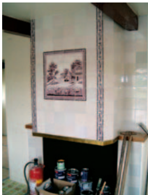
De oorspronkelijke tegelschouw, is in de oude stijl, met tegeltableau, teruggebracht.
