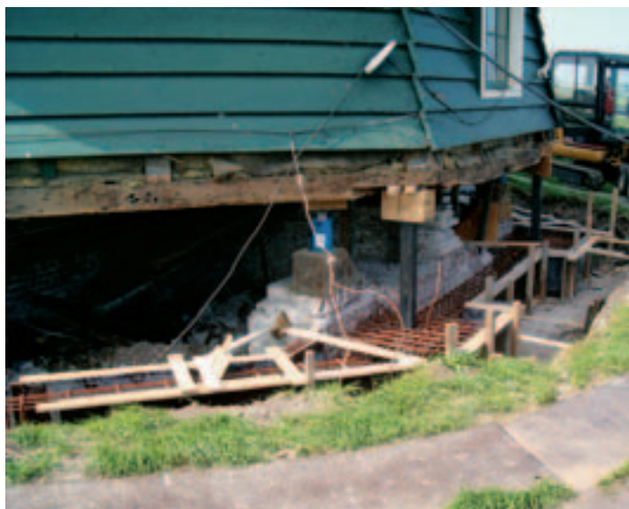
De molen is rechtgezet en voorzien van nieuwe heipalen en betonfundering
