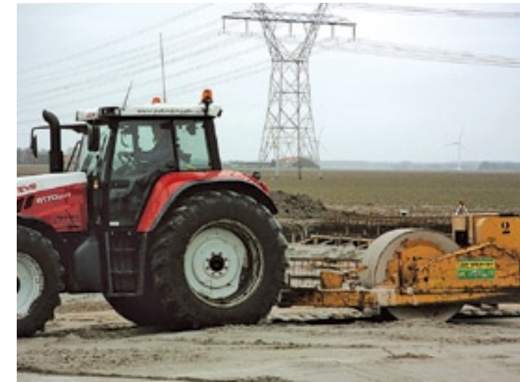
▲ Bij grondverbetering is het essentieel dat het zandbed wordt aangetrild.
