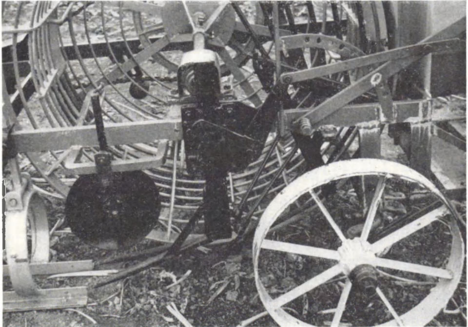
Afb. 16. Detailopname van de Roerslev korfrooier
