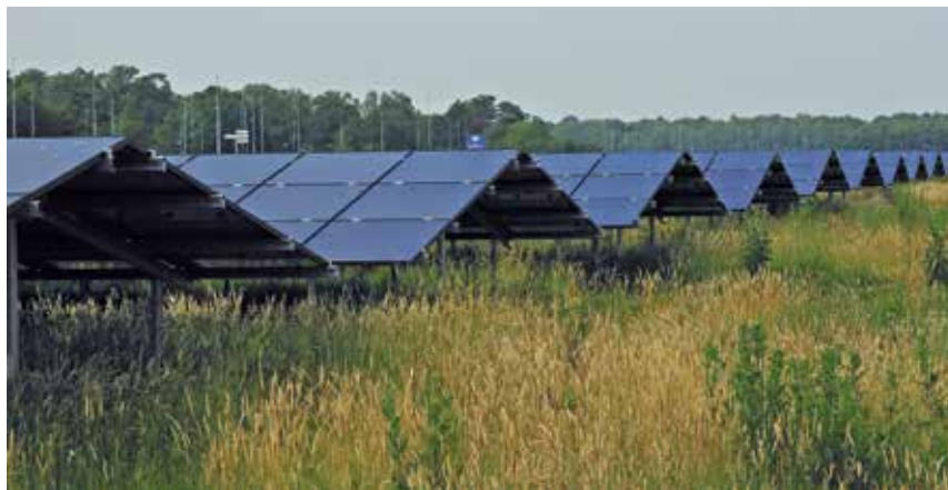
Figuur 2 Bij een zonnepark met een oost-westopstelling van de panelen is vaak weinig ruimte tussen de rijen en minder mogelijkheden voor combinatie met andere functies (Foto: Friso van der Zee).
