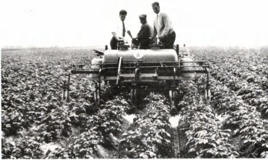
Afb. 1 "Selectief" vlammen met de Maywick Kerovator (petroleum) voor onkruidbestrijding in aardappelen.
