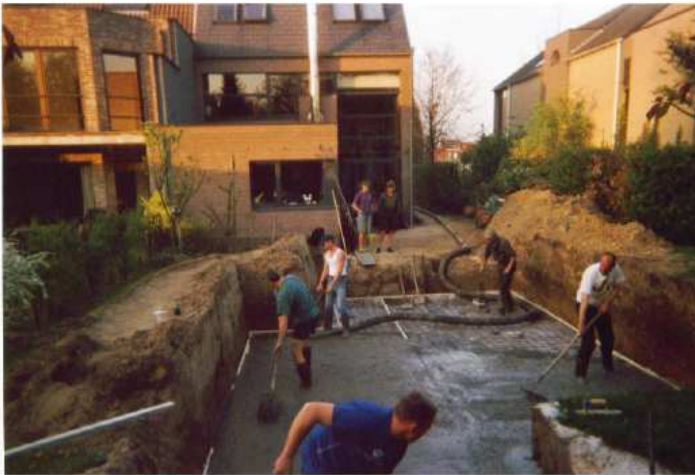
Figuur 23: storten en gelijktrekken beton
