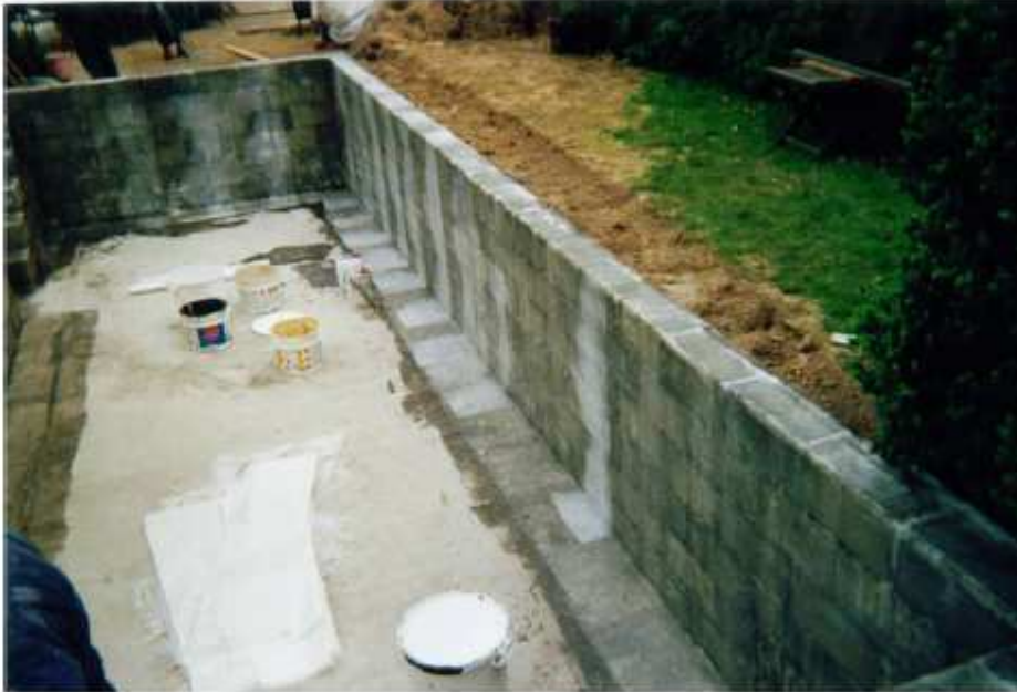
Figuur 29: plaatsing van de glasvezelmatten
