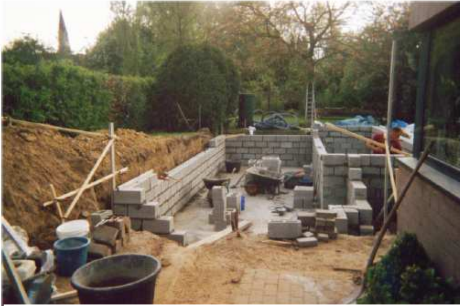
Figuur 27: het metsen van de hoeken naar het midden toe
