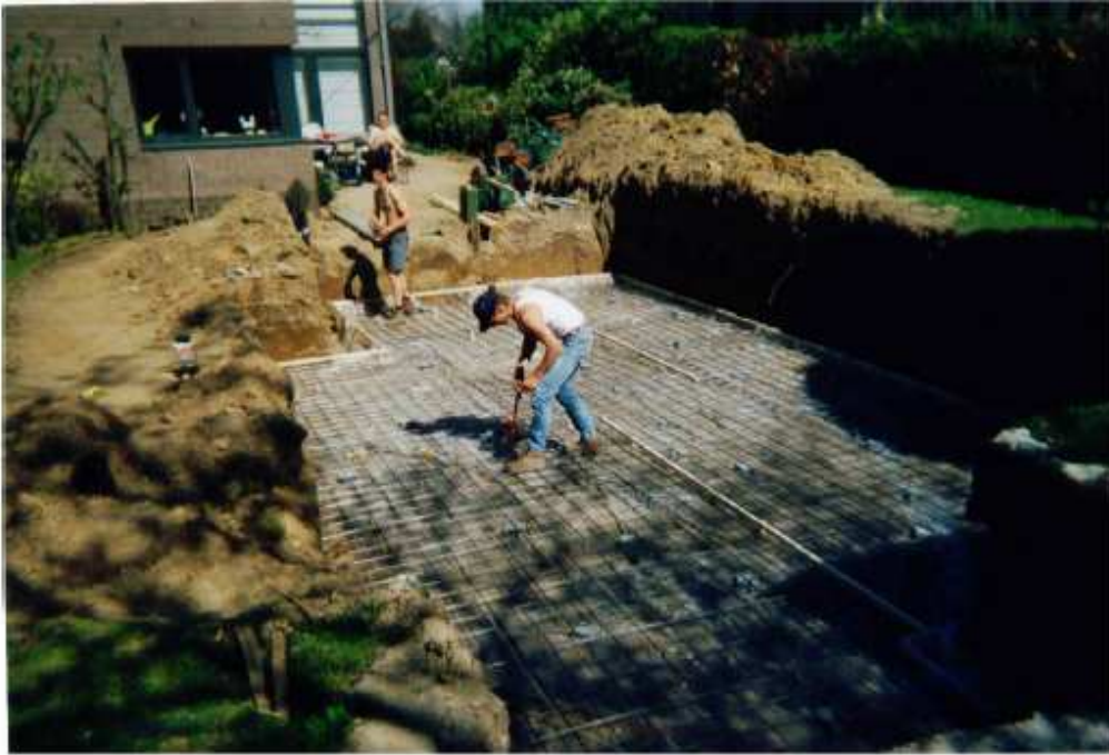
Figuur 21: plaatsing van de betonnetten en verbinden
