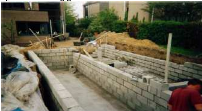
Figuur 28: afwerken metselwerk
