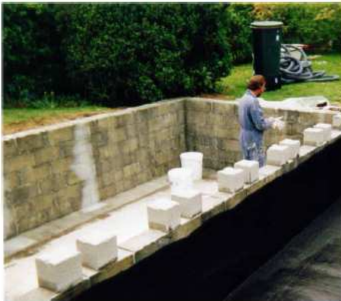
Figuur 31: fundering stapstenen
