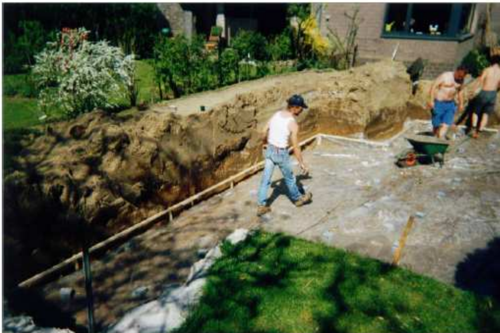
Figuur 18: plaatsen van de omkassing en de folie
