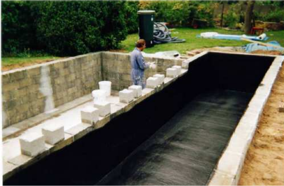
Figuur 30: aanbrengen zwarte topcoat
