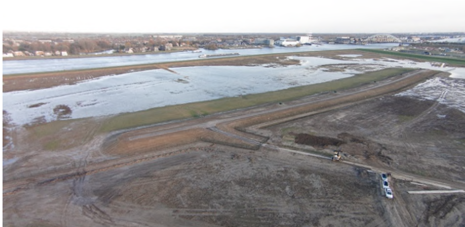
Figuur 11-10 Winputten op een speciaal aangelegde dijk in de Crezéepolder (foto Oasen).
