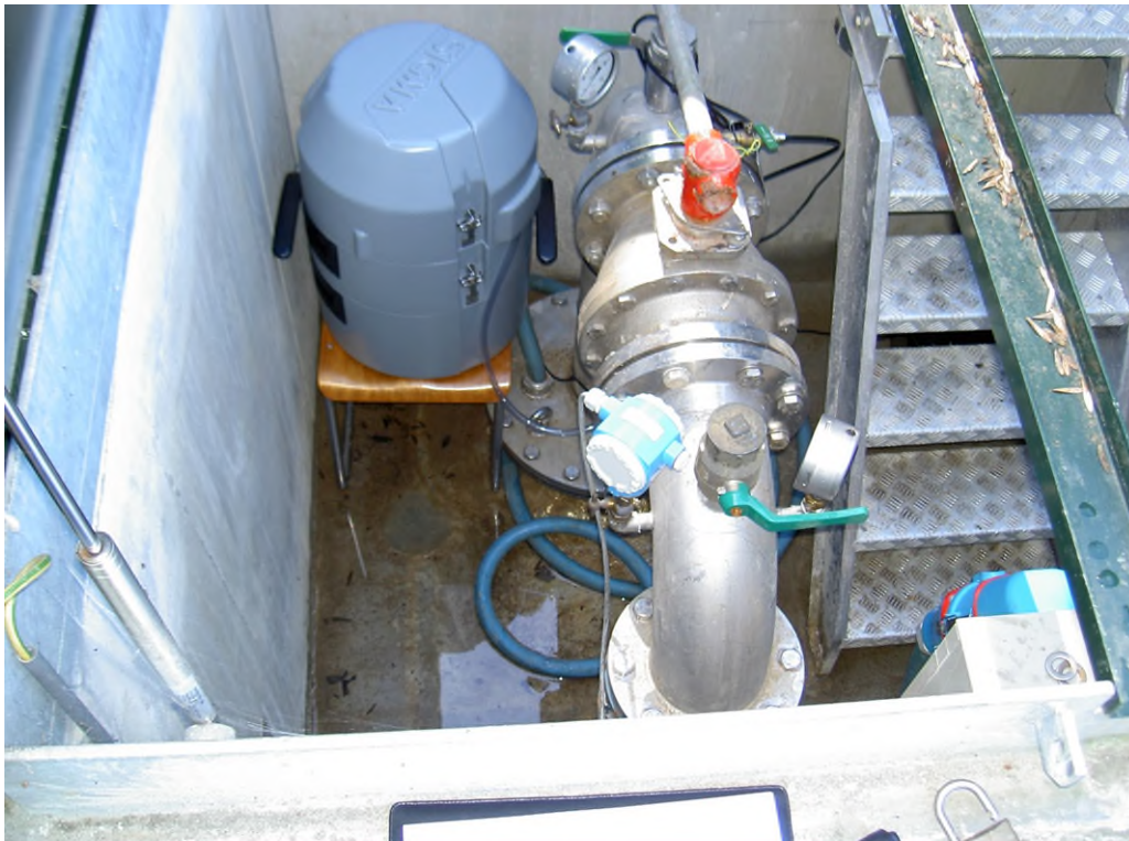
Figuur 12-10 In een betonnen putkelder afgewerkte putkopconstructie (foto WML).
