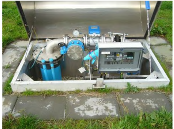
Figuur 12-8 Bovengronds afgewerkte winput (SBW, 1995); rechts: bovengronds afgewerkte put in Onnen (foto Waterbedrijf Groningen).
