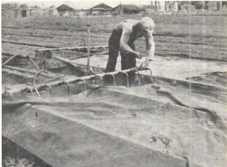
Fig. 4. Grondafdekking met een zeil
