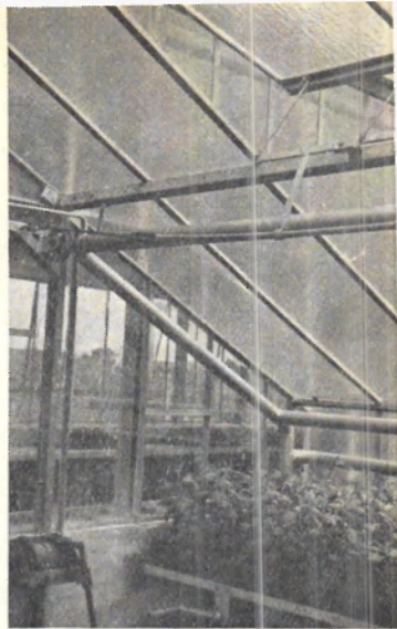
Trekstang voor luchtmechanisme in kweekkas (Kraehe en Woehr) met ruiten van gehamerd glas
