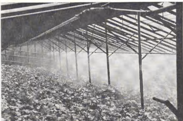
Kas met sproeiinstallatie (Perrot), 1-zijdige ketsdoppen en toevoerpijpen als verwarmingspijpen
