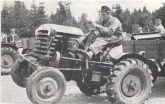
Trekker (Alpenland) met vierwielbesturing, op 2 wielen voor zwaar beladen wagen
