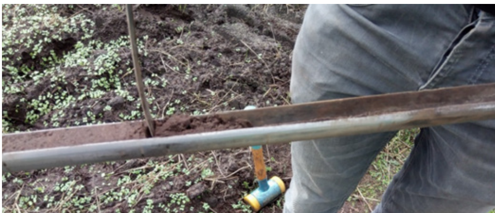
Figuur B1.8 Verwijderen van ingevallen grond.
