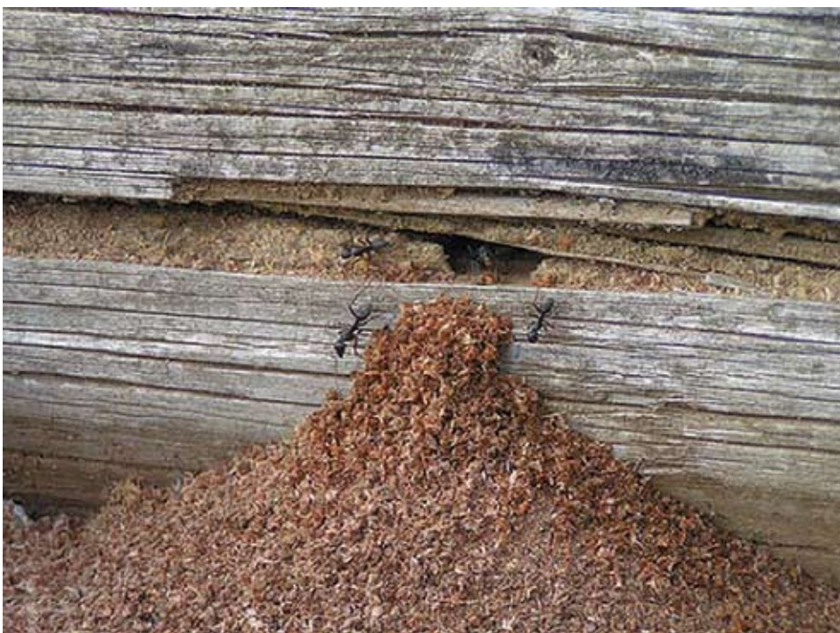
Figuur 1. Nest van de zwarte reuzenmier in een spoorbiels Foto: onbekend (via François Vankerkhoven) Nest of Camponotus vagus in a railway sleeper.
