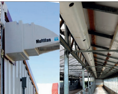
Mechanische ventilatie voor elk individueel kalf
