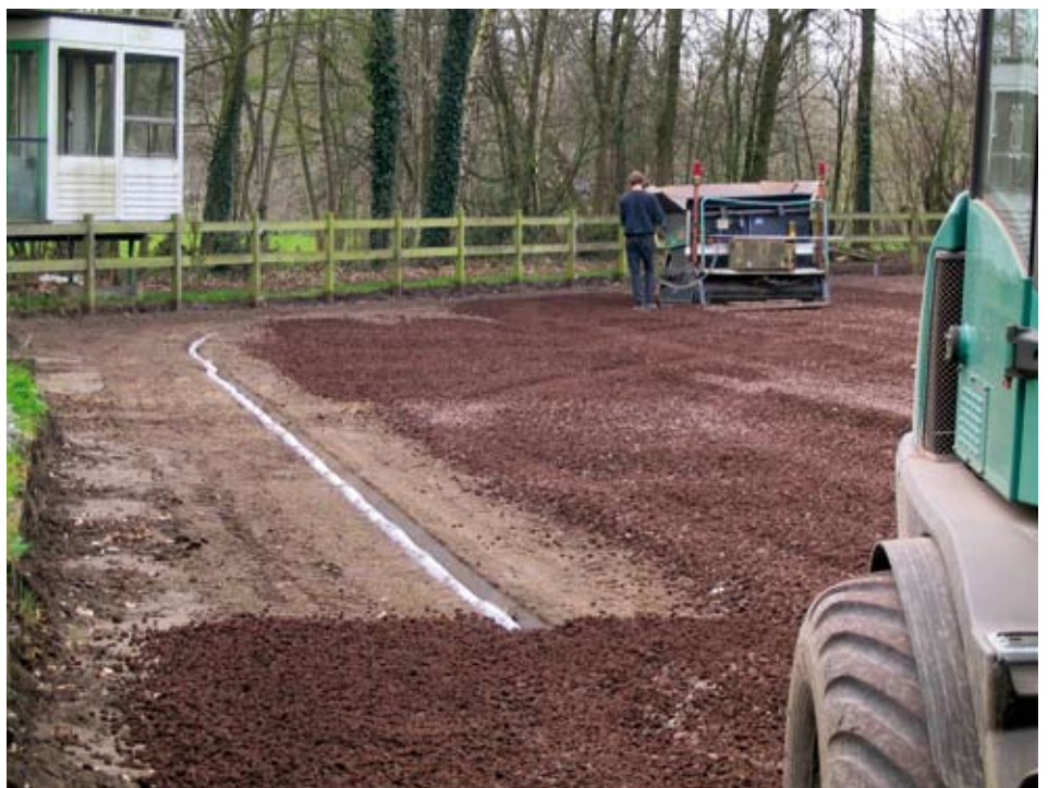
In de ondergrond zijn sleuven aangebracht voor de drainage. De 15 centimeter dikke lavalaa wordt uitgevlakt.
