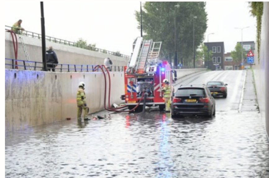
Ondergelopen Tunnel in Woerden 5 september 2018 (97 mm neerslag)
