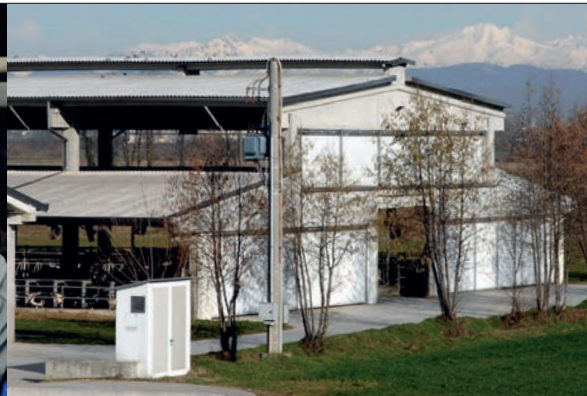
De dakconstructie brengt de winterzon in de stal
