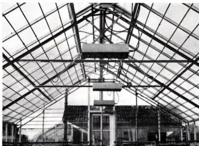
Zeer lichtgebouwde kweekkas met grote glasmaat, dunnepijp- verwarming en hogedruk kwiklampen (proeftuin I.T.T.)
