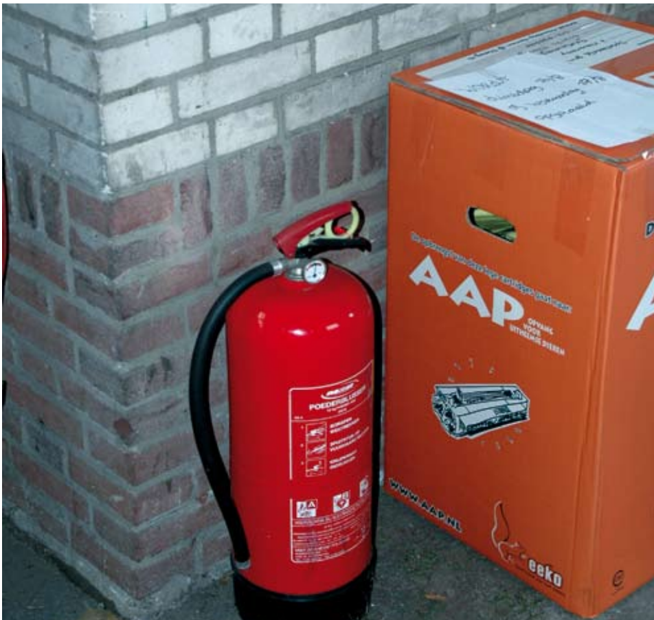
Hier staat een doos naast de brandspuit. De kans is groot dat die brandblusser binnen de kortste keren vol geparkeerd staat met andere dozen. Dan is die niet meer te zien tegen de tijd dat de pleuris uitbreekt en je in allerij naar de brandblusser op zoek bent.
