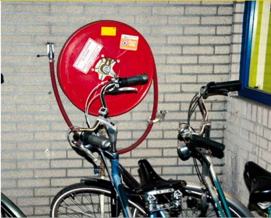
Dit is natuurlijk levensgevaarlijk: fietsen voor de brandslang. Behoeft verder weinig commentaar.
