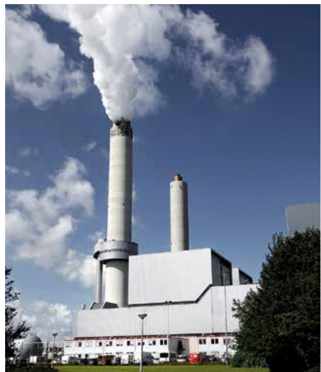
➔ Afval Energie Bedrijf (AEB) te Amsterdam.
