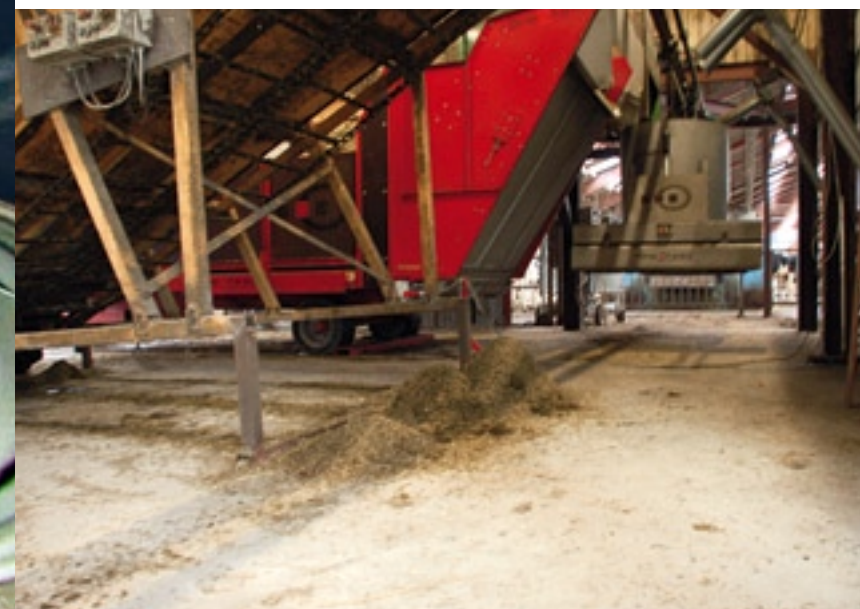
Grøn wilde geen geknoei van voer onder de bunker. De nieuwe bunker is daarom voorzien van een walking floor.
