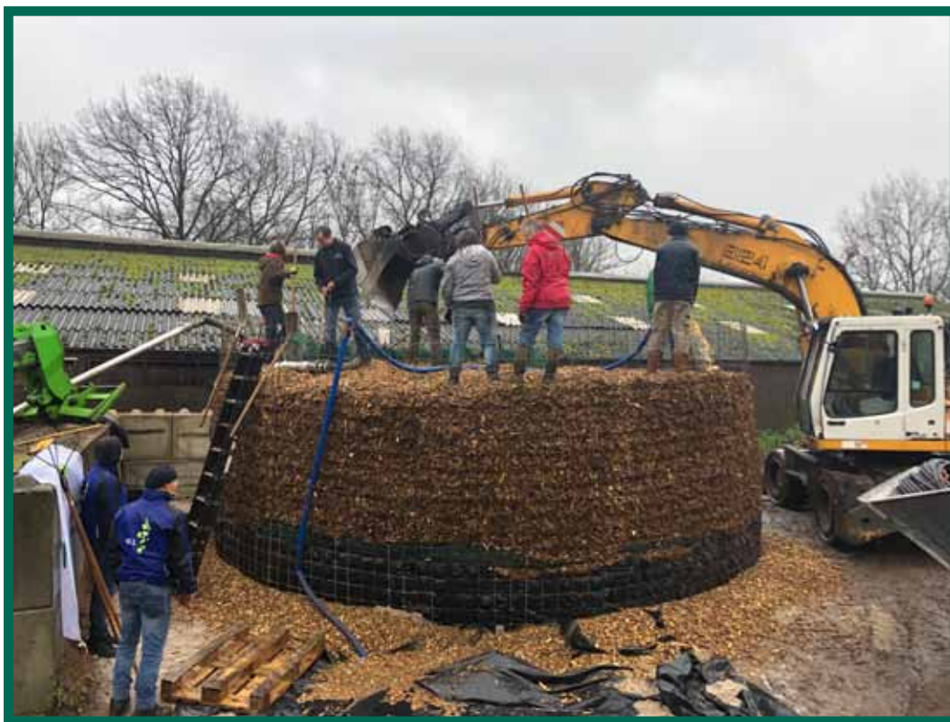
In Voerendaal werd snoeisels van hagen en struiken uit de omgeving verzameld en verwerkt in een bio-meiler. De biomassa gaat broeien in de bio-meiler, waarna de ontstane warmte wordt gebruikt om een nabijgelegen gebouw te verwarmen. Om het gebouw te verwarmen zou anders de uitstoot van 18,3 ton CO 2 plaatsvinden door de verbranding van aardgas.
